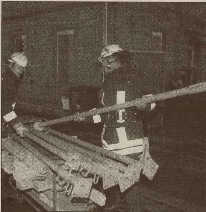
Nachdem der Löscheinsatz beendet war, trug die Wehr Stahlsprößen ins Haus, um eine Decke zu sichern. Bild: Zimmermann
